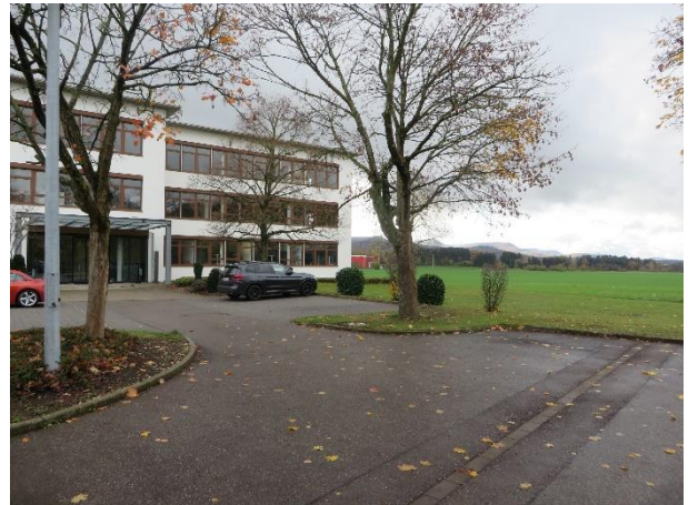
Foto 10: Einzelbäume vor Gewerbegebäude
