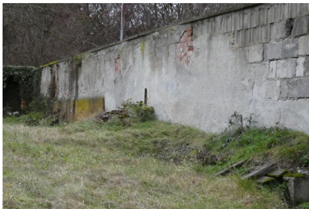
Abb. 2: nördliche Mauer am Flurstück 14/3
