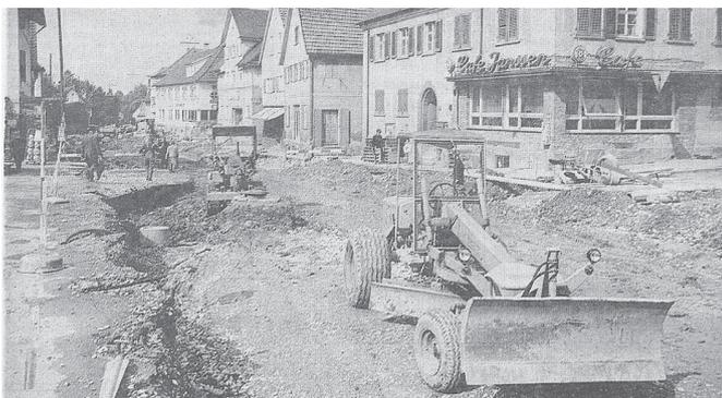
„Mit Hochdruck werden die Arbeiten vorangetrieben... Die neue Breite der Ortsdurchfahrt beträgt 8,50 Meter. Außerdem sind entlang der Straße 2 Meter breite Gehwege vorgesehen“, lautete der Text damals in der Geislinger Zeitung. Weiter konnte man lesen, dass 500.000 Mark Gesamtkosten für den Bauabschnitt Sportplatz bis Rathaus veranschlagt und im Bundeshaushalt bereitgestellt waren. Im Zuge dieser Arbeiten wurden auch Fernmeldekabel und eine neue Gasleitung verlegt.
