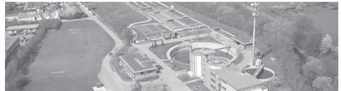
Das Klärwerk des Abwasserzweckverbands Mittlere Fils ist derzeit für die Abwasserreinigung von rund 85.000 Einwohnern zuständig. Die Verfahrenstechnik setzt sich aus mechanischen, biologischen und chemischen Reinigungsstufen zusammen. Die Schlammbehandlung besteht aus Schlammfäulung und Zentrifugentwässerung. Das Klärgas wird mittels BHKW zur Stromerzeugung genutzt.
