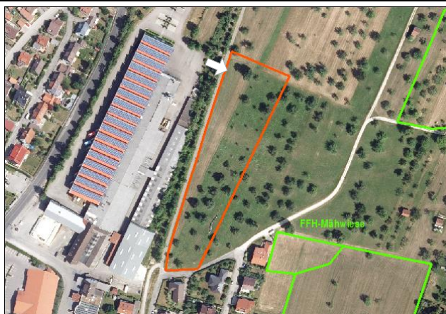
Luftbild Plangebiet mit Standort Foto / Blickrichtung
